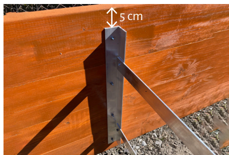
7. Do středu delších stran dodanými vratovými šrouby a matkami přišroubujte vzpěry. V profil je o 10 cm kratší, než výška záhonu. Přišroubuje tak, aby začínal i končil 5 cm od okrajů záhonu.
