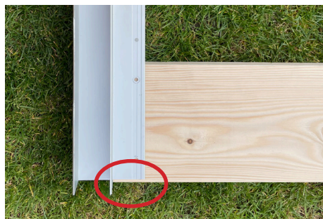
1. Nasuňte fošnu do hliníkového rohu, fošna by měla cca 2 mm vyčuhovat.
