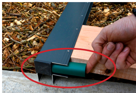
2. Začínáme od spodu - nasadíme záslepky a použijeme distanční váleček - profil je předvrtaný tak, aby dole vznikla mezeru pro přístup vzduchu
