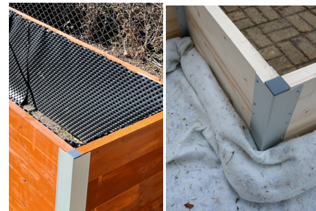
9. Vnitřní stěny záhonu doporučujeme izolovat nopovou fólií. Pokud záhon stojí na betonu nebo dlažbě, vystelte dno geotextilií. Předejdete vyplavování substrátu mezerou mezi dolní hranou záhonu a podlahou.
