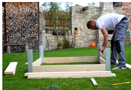
5. Po sestavení první řady nasuňte ostatní fošny do zbývajících řad. Dbejte na to, aby mezi fošnami nezůstaly mezery.
