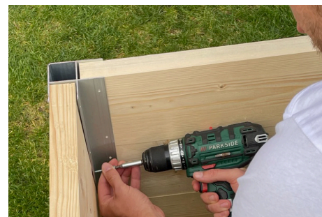
6. Dbejte na to, aby mezi fošnami nezůstaly mezery. Nejlépe to půjde poklepáním na horní hranu gumovou paličkou.
