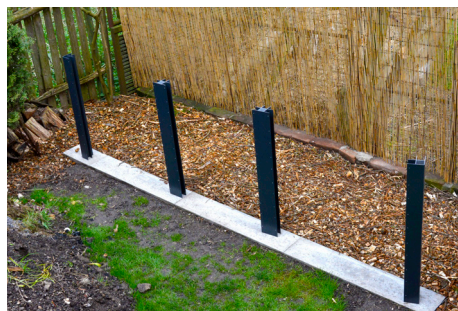
1. Připravte si zvenku předvrtané hliníkové profily, které chcete mít rozebíratelné.
