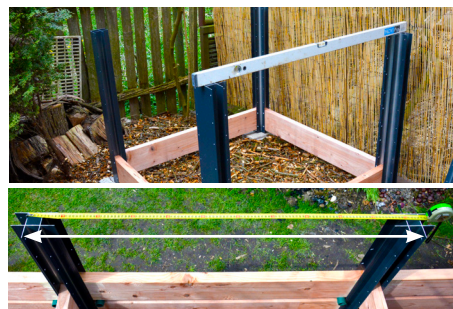
5. Zkontrolujte, zda je vše ve vodováze, a také, zda je rozestup profilů v horní části shodný s první vrstvou.
