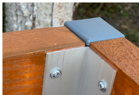
8. Nakonec na všechny hliníkové rohy nasadte plastové záslepky. Fošna mírně přesahuje hliníkový profil. A je hotovo! 😊
